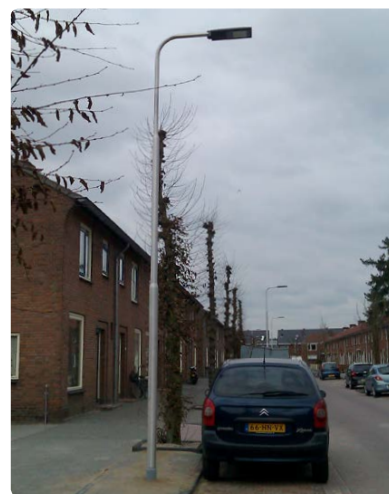
Referentiebeeld mast met enkelvoudige uithouder (lengte = 0,75 m, tilt 5°).
