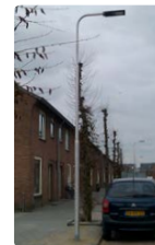
Referentiebeeld diepstralend armatuur Piano (links) en mast met enkelvoudige uithouder (lengte = 0,75 m, tilt 5°).
