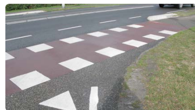
Referentiebeeld markering op asfaltverharding
