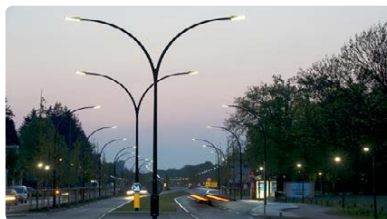
Referentiebeeld verlichting hoofdinfrastructuur
