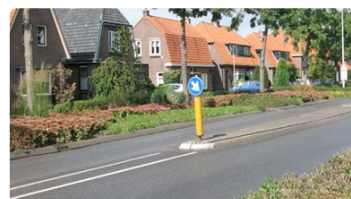
Referentiebeeld rijbaan hoofdinfrastructuur
